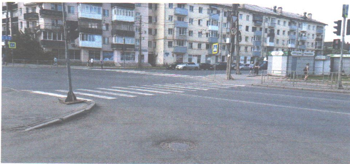
Перекресток улиц Кирова и Ленинградской
